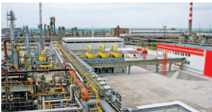
Нефтеперерабатывающий завод, г. Бургас Объект компании «Лукойл»
