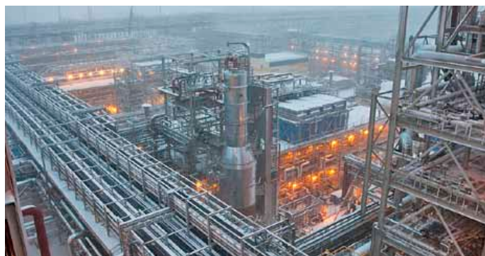
КНС комплекса нефтеперерабатывающих и нефтехимических заводов, г. Нижнекамск Объект компании «Татнефть»
