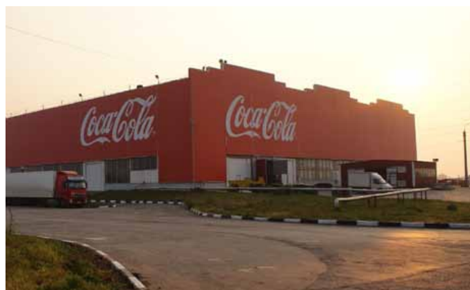
Системы водоподготовки завода по производству безалкогольных напитков, г. Москва
