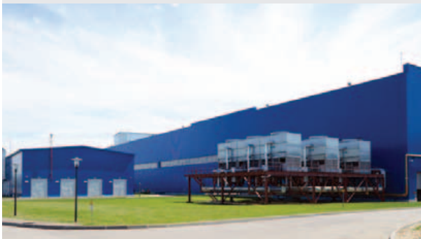
«Яндекс» дата-центр в Рязанской области
